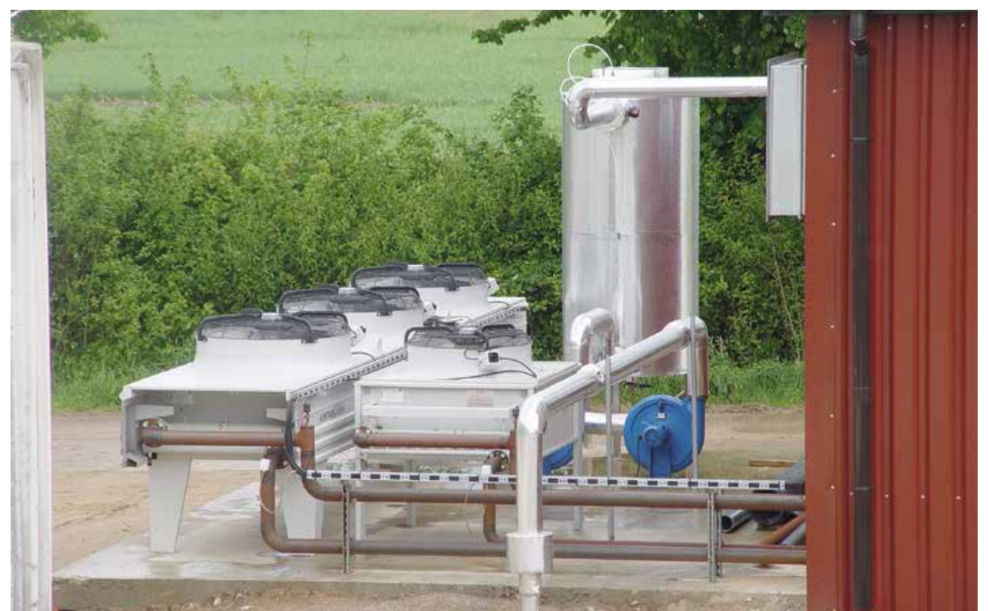
Kohlefilter zur Gasreinigung, Motorkühler
