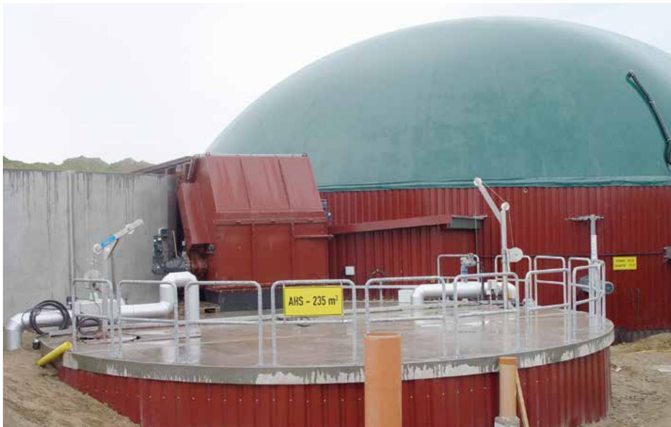
Futterbehälter mit Deckel, Anmaischgrube (AHS) und Fermenter mit Gashaube
