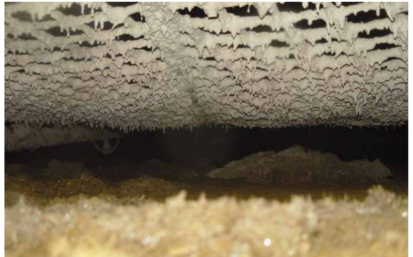
Blick in den Fermenter, Schwefel am Netz
