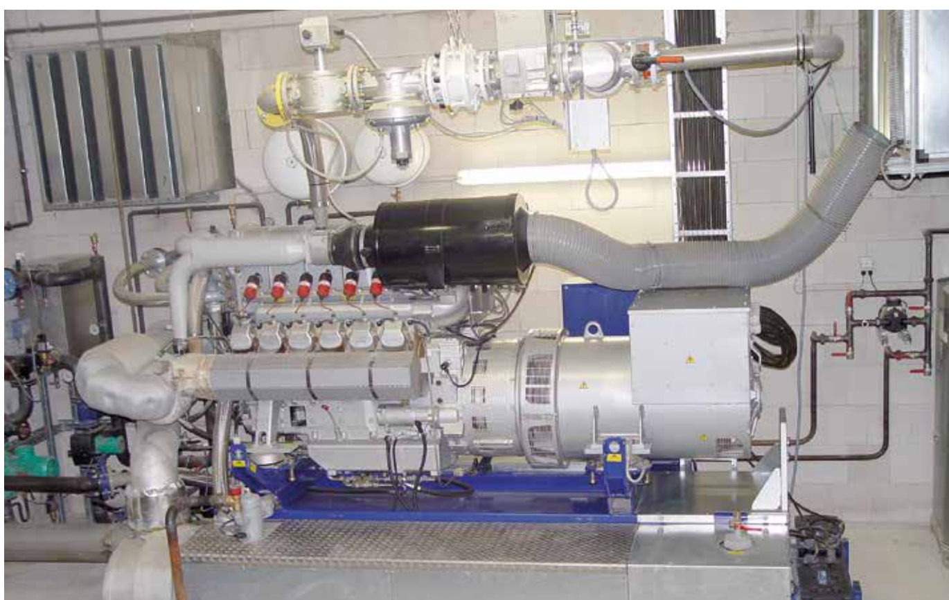
12 Zylinder Gasmotor mit 390 kW
