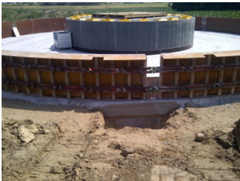
Die Schalung wird auf die Sauberkeitsschicht aufgebracht und befestigt.
