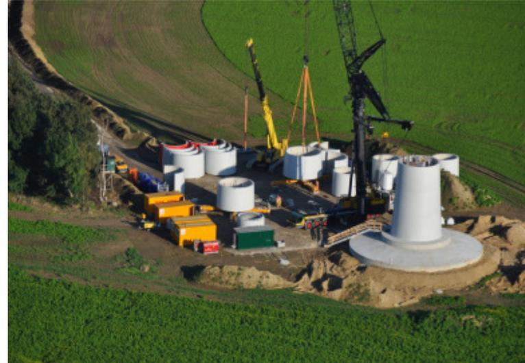
Nach und nach werden die einzelnen Betonturmteile aus zwei Halbschalen zusammengesetzt und anschließend aufeinandergesetzt.
