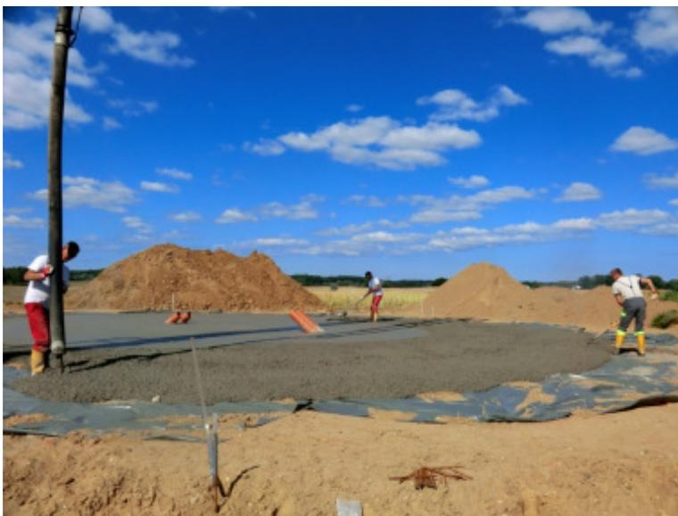
Der nichttragfähige Boden wird durch ein Kiessandpolster ersetzt und eine Sauberkeitsschicht aus Beton wird gegossen.
