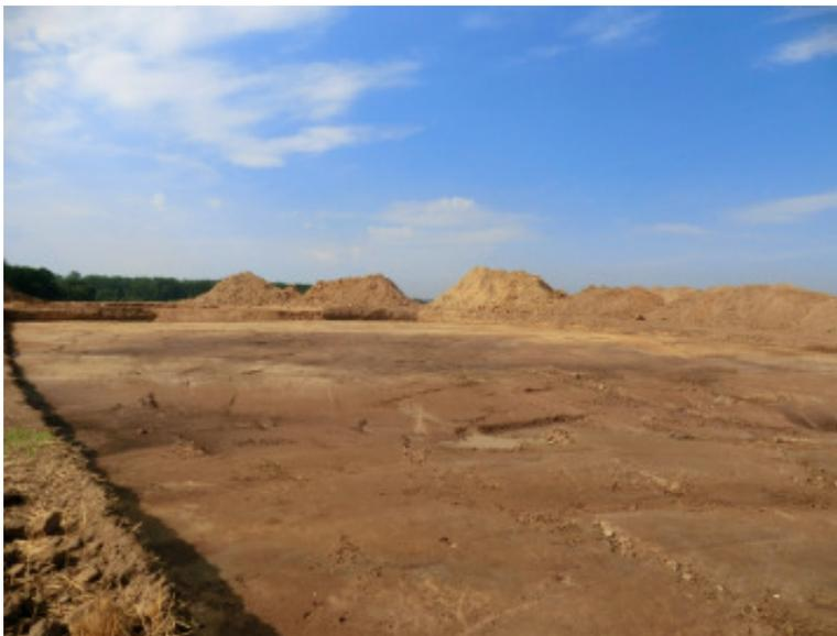
Auch für die Baugrube wird zuerst der Mutterboden und dann der nicht tragfähige Boden ausgehoben.
