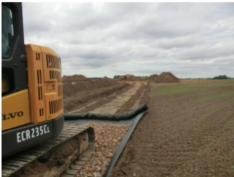
Für die Herstellung der Wege wird der Mutterboden abgetragen, ein Geotextil ausgelegt und eine Trag- und Deckschicht aus Betonschotter aufgebracht.
