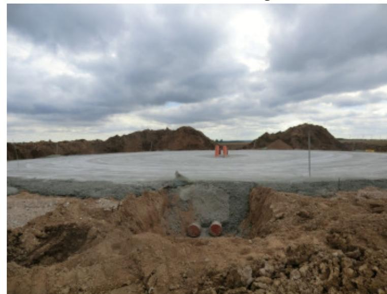
In die Sauberkeitsschicht werden bereits Lehrrohre für die spätere Einführung der Anschlusskabel eingearbeitet.
