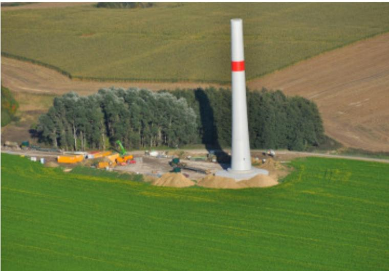
Der gesamte Betonteil des Turmes ist 57 m hoch und wiegt ca. 750 t. Der Turm wird zudem mit Stahllitzen im inneren verspannt.
