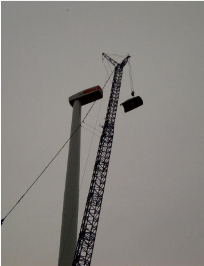
Auf den Betonturm wird ein Stahlrohrturm montiert. Dieser besteht aus drei Einzelteilen, welche zusammen ca. 65 m lang sind und ca. 140 t wiegen. Das oberste Turmteil (ca. 40 t) und die Gondel (ca. 113 t schwer und 13 x 4,5 x 4,5 m groß) werden aus statischen Gründen immer zusammen montiert.
