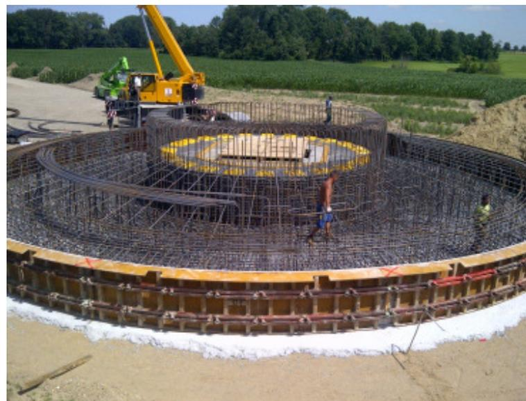
Ca. 80 t Stahl und 650 m<sup>3</sup> Beton sorgen für den sicheren Stand der Anlagen.
