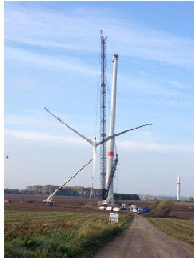
Der Rotor hat einen Durchmesser von 104 m und wiegt ca. 60 t. Er überstreicht eine Fläche von ca. 8.500 m<sup>2</sup>, was in etwa der Fläche eines Fußballfeldes entspricht. Die gesamte Anlage inkl. Fundament, Turm, Gondel und Rotor wiegt zusammen ca. 2.700 t.
