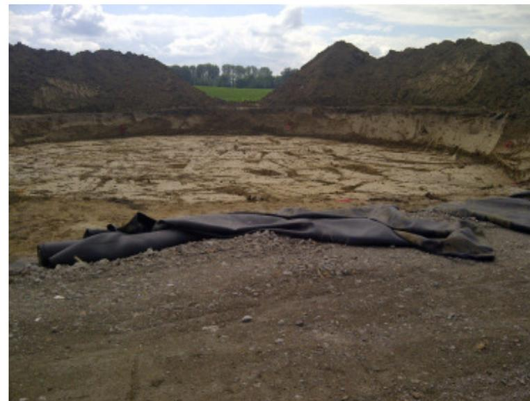
Für das Fundament wird je nach Bodenbeschaffenheit ein Aushub von ca. 500 m<sup>3</sup> notwendig.
