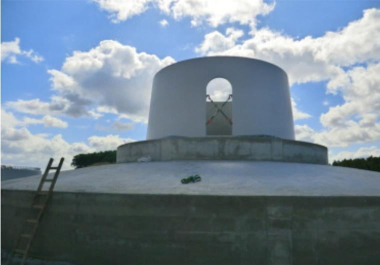
Das unterste Betonturmteil hat einen Durchmesser von 8,10 m und wiegt ca. 60 t. Das oberste Betonteil hat einen Durchmesser von 4,40 m und wiegt ebenfalls ca. 60t.
