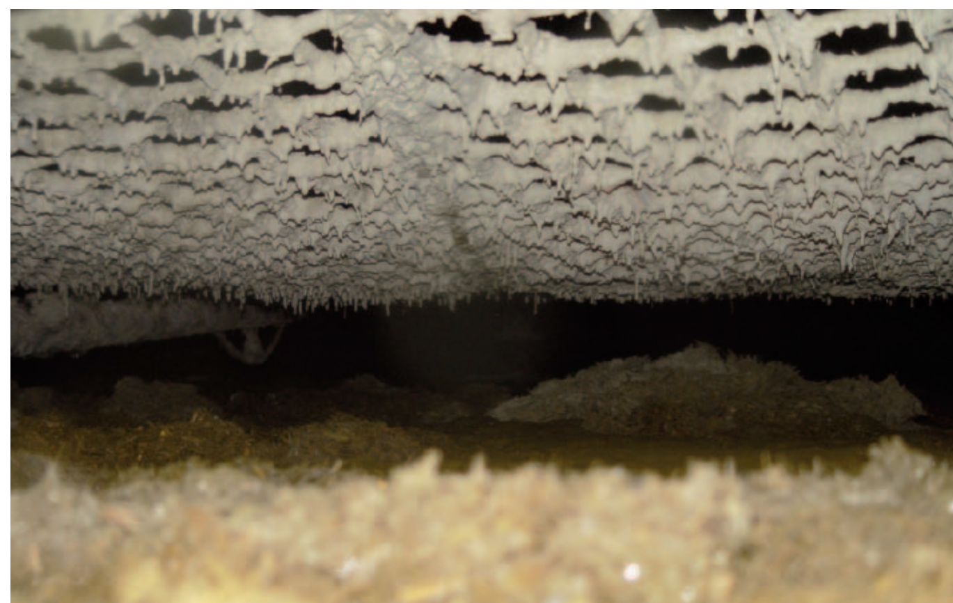
Blick in den Fermenter, Schwefel am Netz
