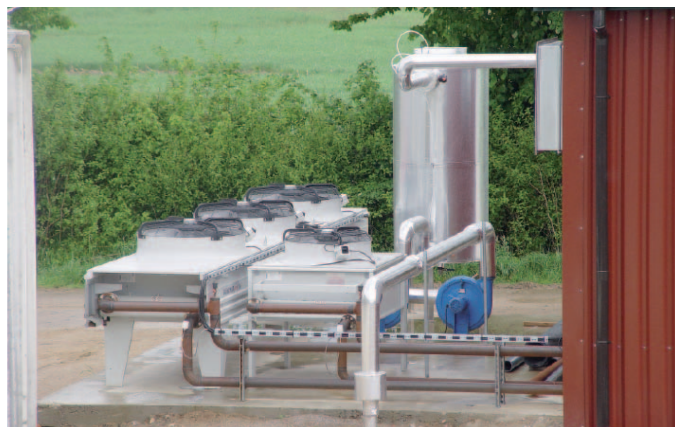
Kohlefilter zur Gasreinigung, Motorkühler
